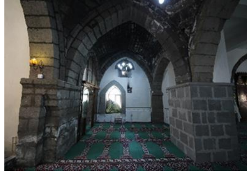
Şekil 17. Orijinal destek ve örtü sistemi
