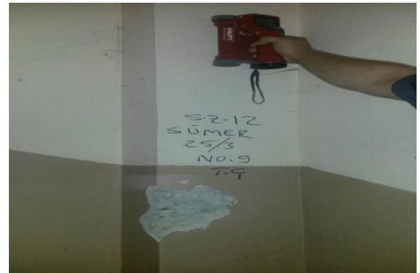
Şekil 2. Okuma yöntemiyle mevcut donatı tespiti
