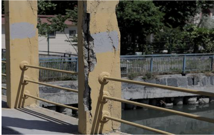
Şekil 16. Askı çubuklarındaki aşınmalar (Fotoğraf yazarlar tarafından çekilmiştir)
