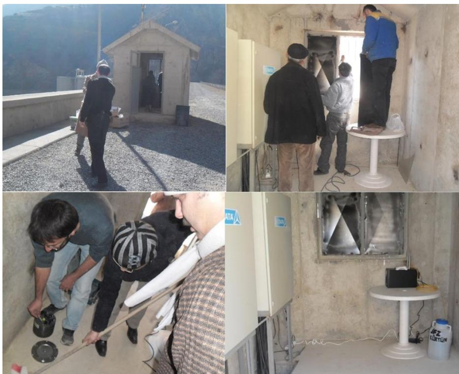
**Şekil 4.** Kürtün HES ivme kayıt istasyonunun kurulumu.
