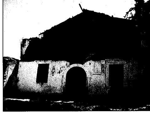
Res. 2) Şirince, Kilise 1 Batı Cephe
