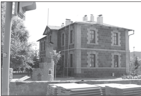
Resim 34: Kars İstasyonu/İşletme Binası
