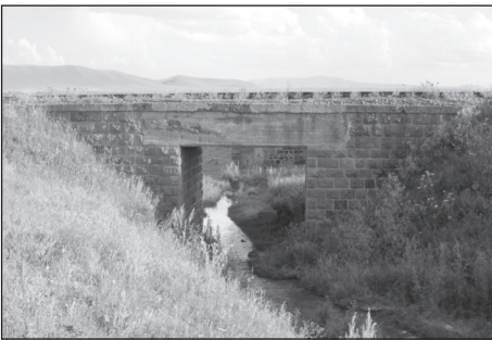
Resim 11: Akyaka-Başgedik Arası/ Duraklı Köyü- Çifte Köprü 01
