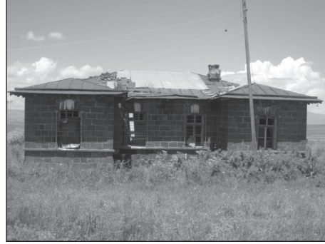
Resim 27: Mezra İstasyonu/ 2 Nolu Lojman Binası
