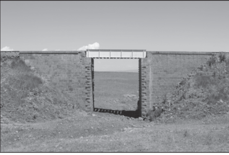
Resim 15: Akyaka-Başgedik/2 Nolu Demir Tablalı Köprü
