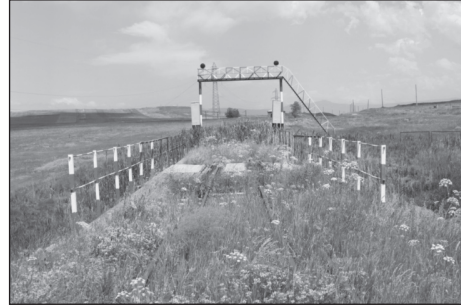
Resim 04: Doğukapı-Demiryolu Sınır Köprüsü Üstü
