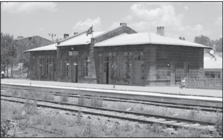
Resim 21: Akyaka İstasyonu/Peron Cephesi
