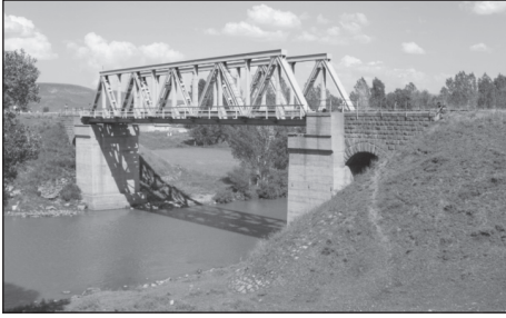
Resim 19: Camuşlu Köyü/Demir Köprü
