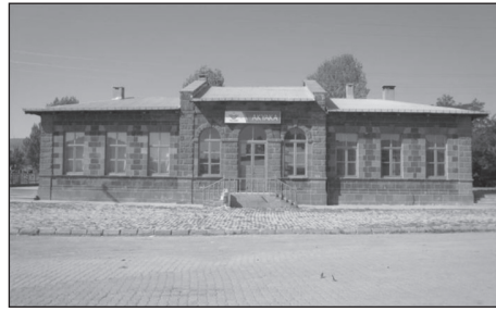
Resim 22: Akyaka İstasyonu/Şehir Cephesi
