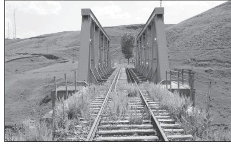
Resim 20: Camuşlu Köyü/Demir Köprü
