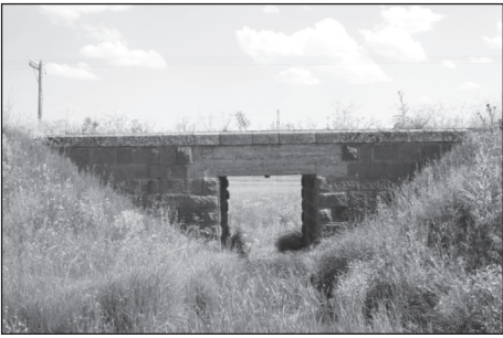
Resim 05: Doğukapı-Akyaka Arası/ 3 Nolu Menfez
