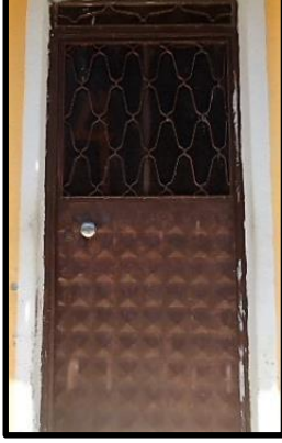
Foto 14: 1 no'lu konut giriş kapısı, Ağaköy
