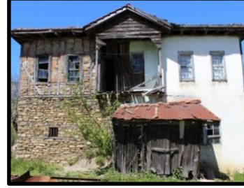
Foto 22: 8 no'lu konut yan cephe, Ağaköy
