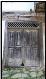
Foto 45: 8 no'lu konut giriş
