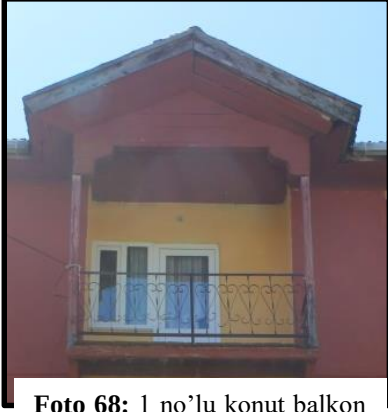
Foto 68: 1 no'lu konut balkon detayı
