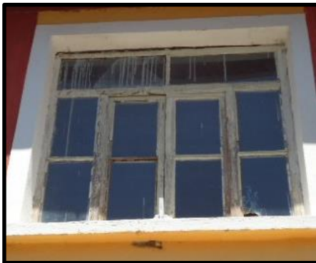
Foto 55: 1 no'lu konut ön cephe penceresi
