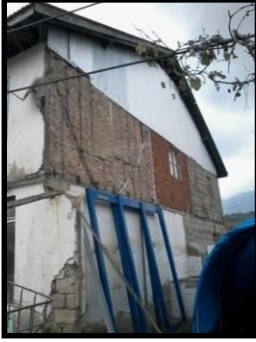
Foto 59: 11 no'lu konut, beşik çatı örneği
