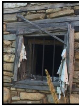
Foto 54: 3 no'lu konut arka cephe penceresi
