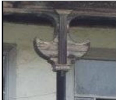
Foto 67: 3 no'lu konut, balkon detayı
