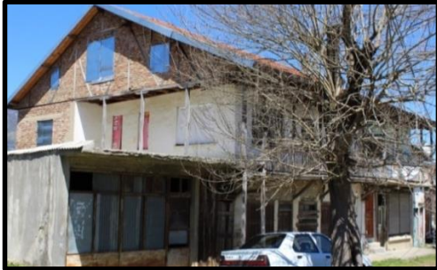
Foto 26: 11 no'lu konut yan cephe, Ağaköy
