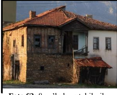
Foto 62: 8 no'lu konut, bileşik kırma çatı örneği
