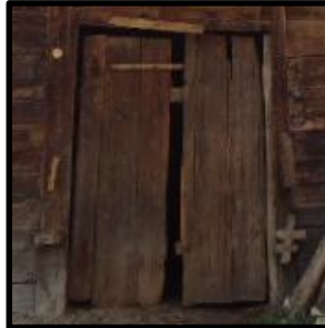
Foto 38: 7 no'lu giriş kapısı
