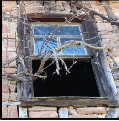
Foto 57: 2 no'lu konut yan cephe penceresi
