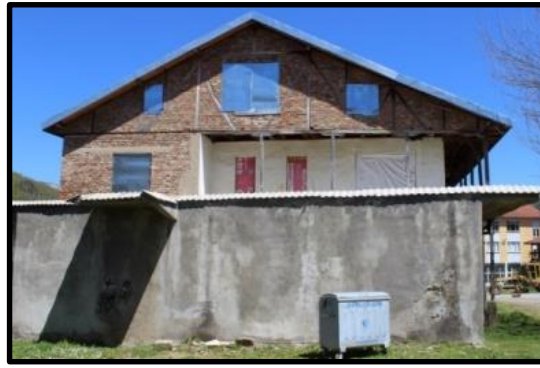
Foto 31: 11 no'lu konut yan cephe, Ağaköy
