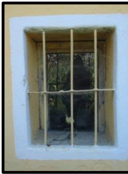
Foto 53: 1 no'lu konut arka cephe penceresi
