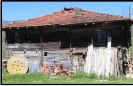
Foto 60: 7 no'lu konut, dört yüzeyli kırma çatı örneği
