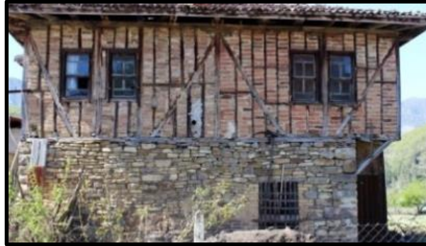
Foto 7: 5no'lu konut yan cephe Ağaköy
