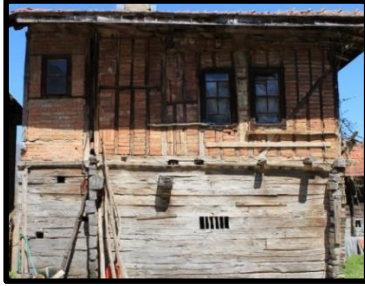
Foto 9: 6 no'lu konut yan cephe, Ağaköy
