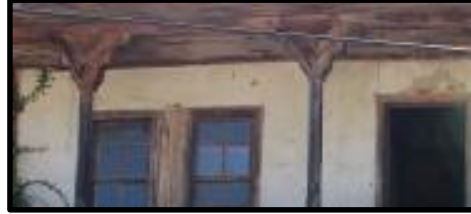
Foto 66: 4 no'lu konut, balkon detayı
