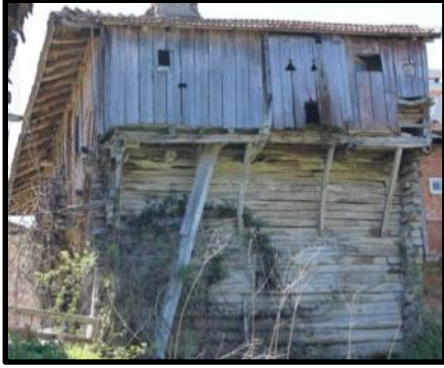
Foto 30: 6 no'lu konut yan cephe, Ağaköy
