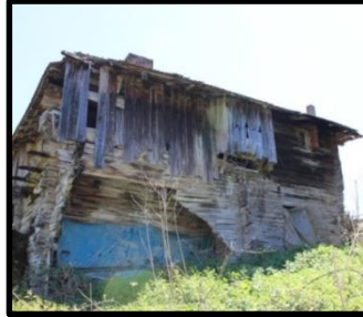
Foto 10: 7 no'lu konut, yan cephe, Ağaköy
