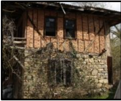
Foto 6: 10 no'lu konut yan cephe Ağaköy
