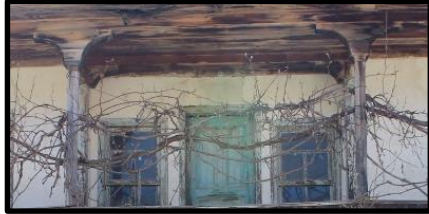
Foto 65: 2 no'lu konut, balkon detayı
