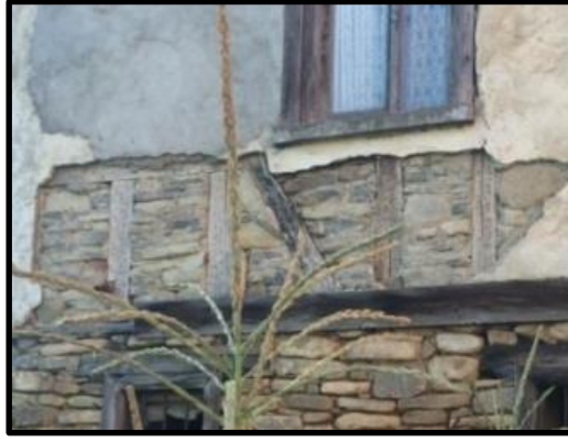
Foto 5: 3 no'lu konut duvar detayı, Ağaköy
