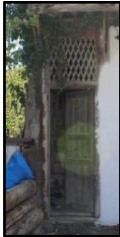
Foto 50: 8nolu konut giriş kapısı
