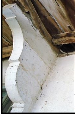
Foto 32: 2 no'lu konut konsol detayı
