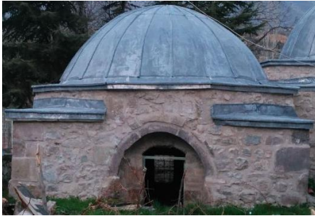
Fotoğraf 12. Ali Paşa Türbesi Girişi
