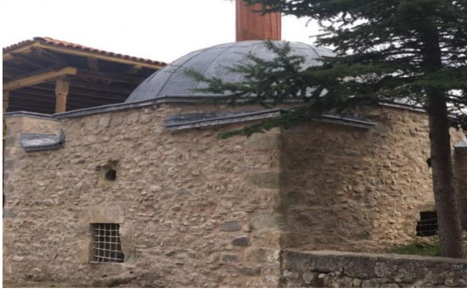
Fotoğraf 4. Hatice Hanım Türbesi'nin Kuzeybatı Cephesi (27.03. 2017)
