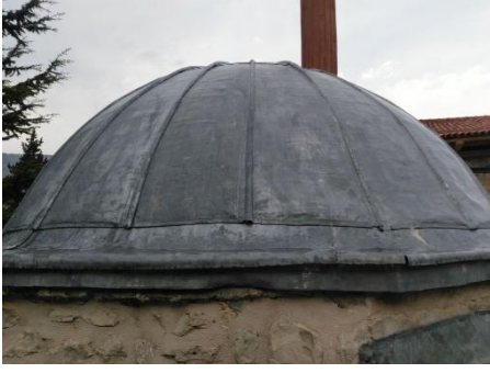
Fotoğraf 7. Kubbenin Sac Kaplaması Görünüşü
