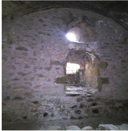
Fotoğraf 6. Batı Duvarın İçten Görünüşü
