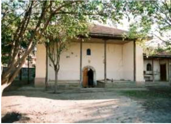
Resim 3. Kuzey Cephe(V.G.M Arş.)
