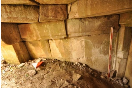
Resim 4: Ön odanın güney duvarından görünüm(T. Alsan).
