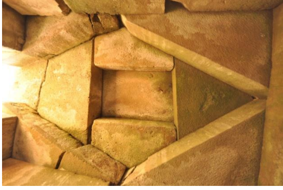
Resim 5: Hamas Kıranı Tümlüsü'nün ön odasında görülen aykırı taşıma tekniğinde yapılmış kubbe örtüsü(T. Alsan).
