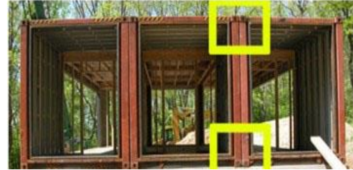
Şekil 4. Standart konteyner bağlantıları, (Socrates, 2012).
