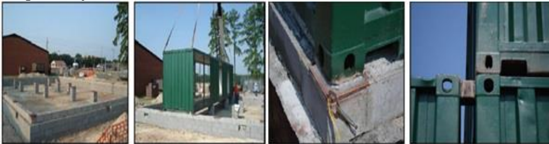
Şekil 5. Standart konteyner temel ve yerleşimleri, (Giriunas vd., 2012).
