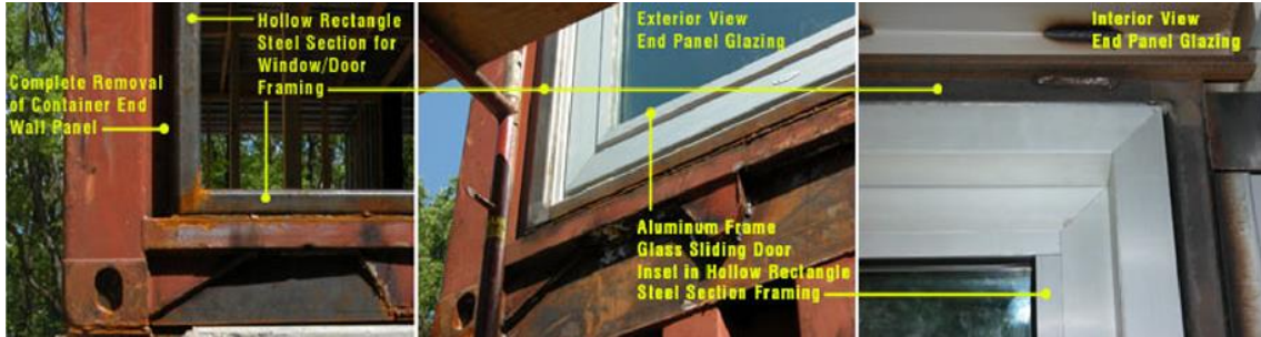
Şekil 6. Standart konteynerlerde kapı ve pencere yerleşimleri, (Socrates, 2012).
