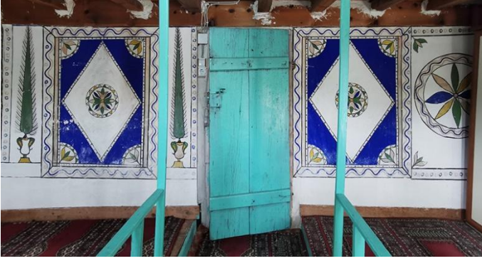
Resim 36. Kuzey Duvarı Kadınlar Mahfeli Altı
