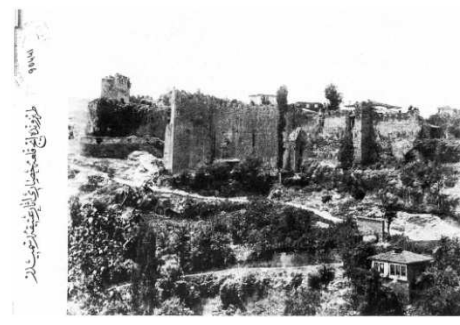
Foto 10: Trabzon Surları (Fortress of Trabzon)
