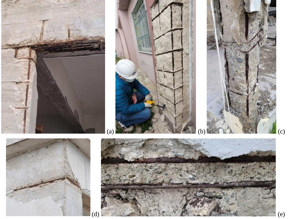
Şekil 6: Korozyon hasarları.
