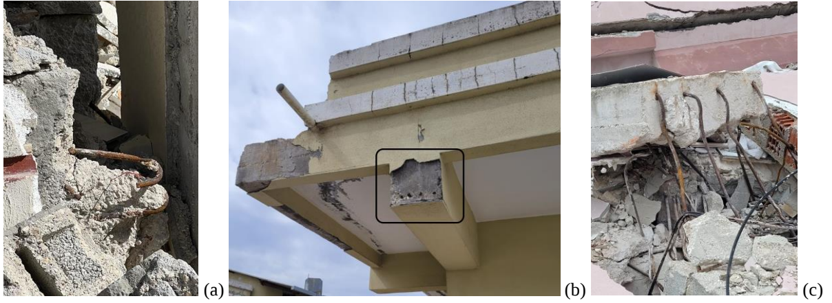
Şekil 7: Hatalı donatı uygulamaları.
