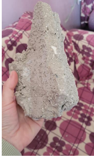
Şekil 15: Kalın sıva uygulaması.
