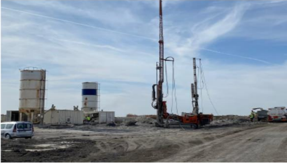
Şekil 2: Jetgrout saha çalışması.
