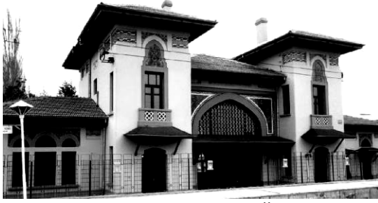
Resim 11. Ankara Gazi Garı Ön Cephesi.
