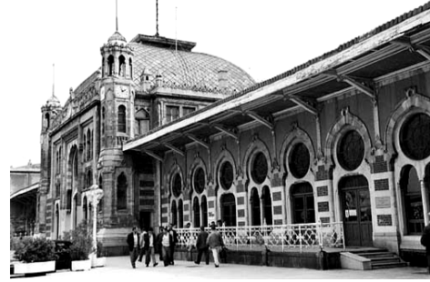
Resim 6. Sirkeci Garı Ön Cephesi.
