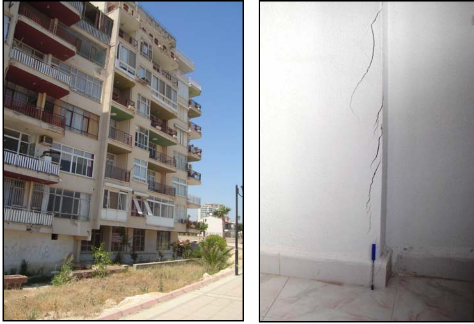
Şekil 9. Bölgedeki yapılarda meydana gelen yapısal hasarlardan bazıları (soldaki fotoğraf şakilden sapmış bir binaya aittir)
