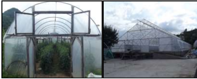
Fotoğraf 4. Giresun'da genellikle yay çatılı(yarım ay şeklinde) ve plastik örtülü seralar yaygın iken, az da olsa beşik çatılı seralar da mevcuttur.
