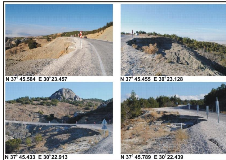
Şekil 2. Isparta-Burdur dağ yolunda meydana gelen heyelanlar
