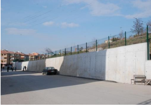
Şekil 10. Çevre istinat duvarından bir görünüm
