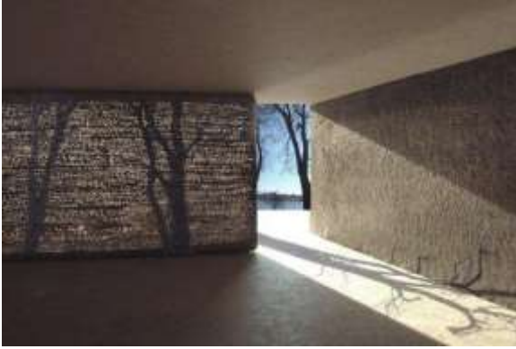
Şekil 2. Yarı saydam beton uygulaması (URL-5, 2017)
