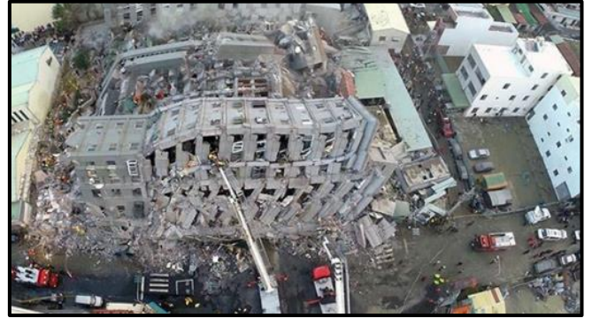
Şekil 4. Kocaeli (1999) depreminde meydana gelen yıkım (URL-2, 2023)
