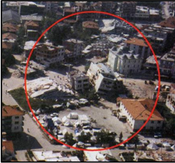
Şekil 8. Adapazarı depreminde meydana gelen zemin yükü oturması örneği (Ulusay, 2000)
