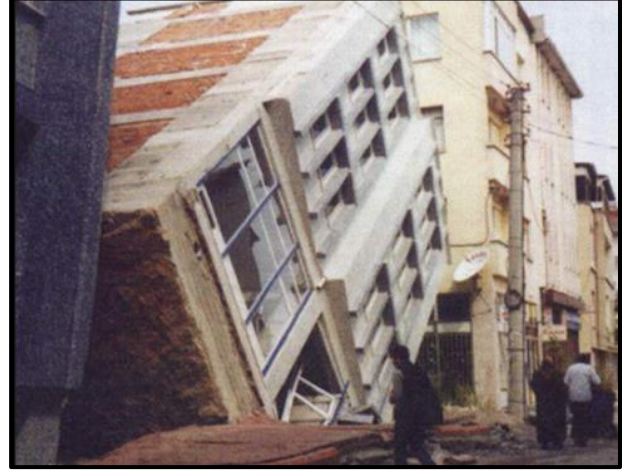
Şekil 9. Adapazarı'nda sıvılaşma nedeniyle devrilmiş bina (Ulusay, 2000)
