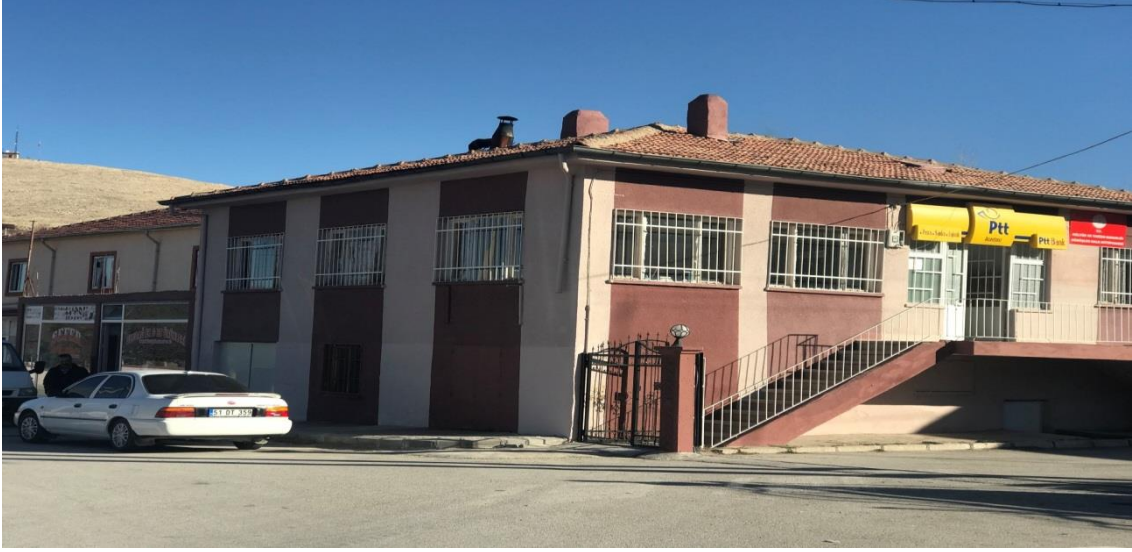
Resim 6: Haberleşmeyi sağlayan PTT binası
