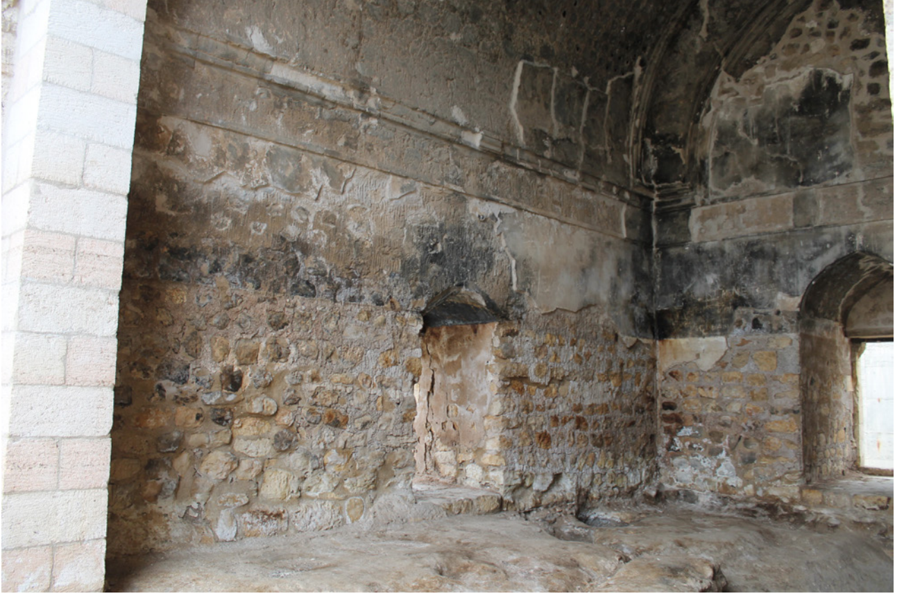
21 Küçük Saray'ın iç mekânı, 2020
