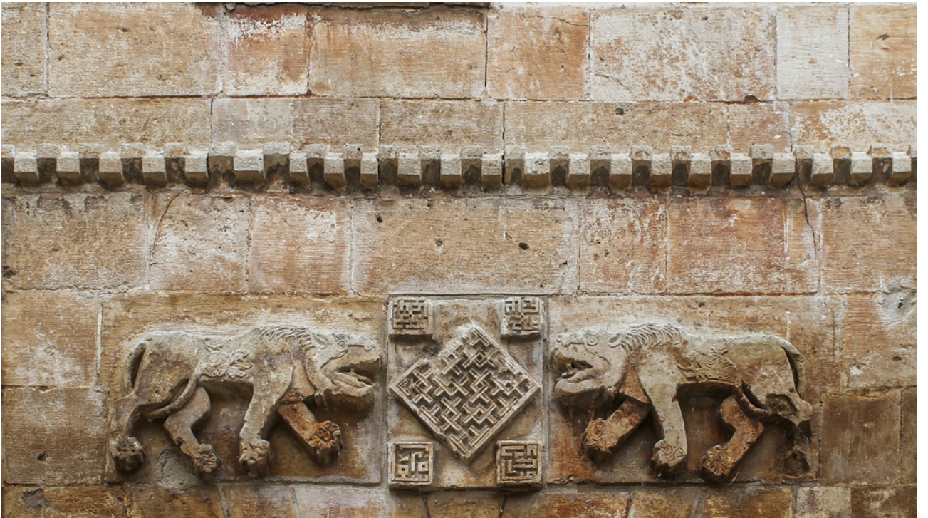
18 Küçük Saray'ın kuzeydoğu cephesindeki bezeme detayı, 2020
