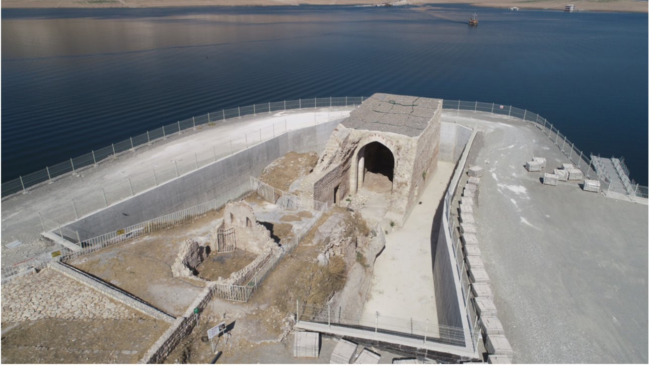
12 Küçük Saray'ın güneybatı cephesi (ERBU, 2020)
