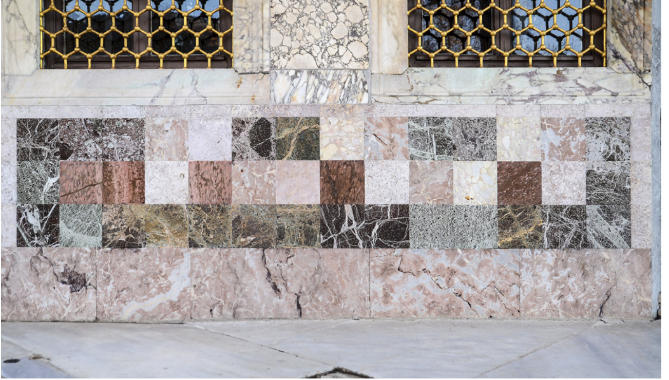
3 Revan Köşkü'nün kuzey cephesinde kare levhalar hâlinde cippollino mandolato , rosso di Francia , rosso di Levante ile oluşturulan pano
