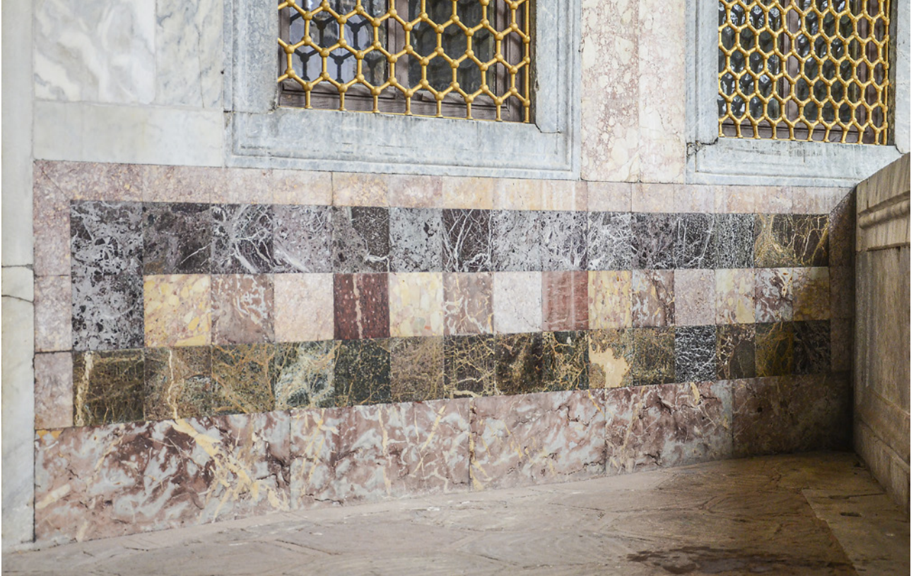
4 Revan Köşkü'nün güney cephesinde kare levhalar hâlinde brocatello , cippollino mandolato , rosso di Francia , rosso di Levante ile oluşturulan pano
