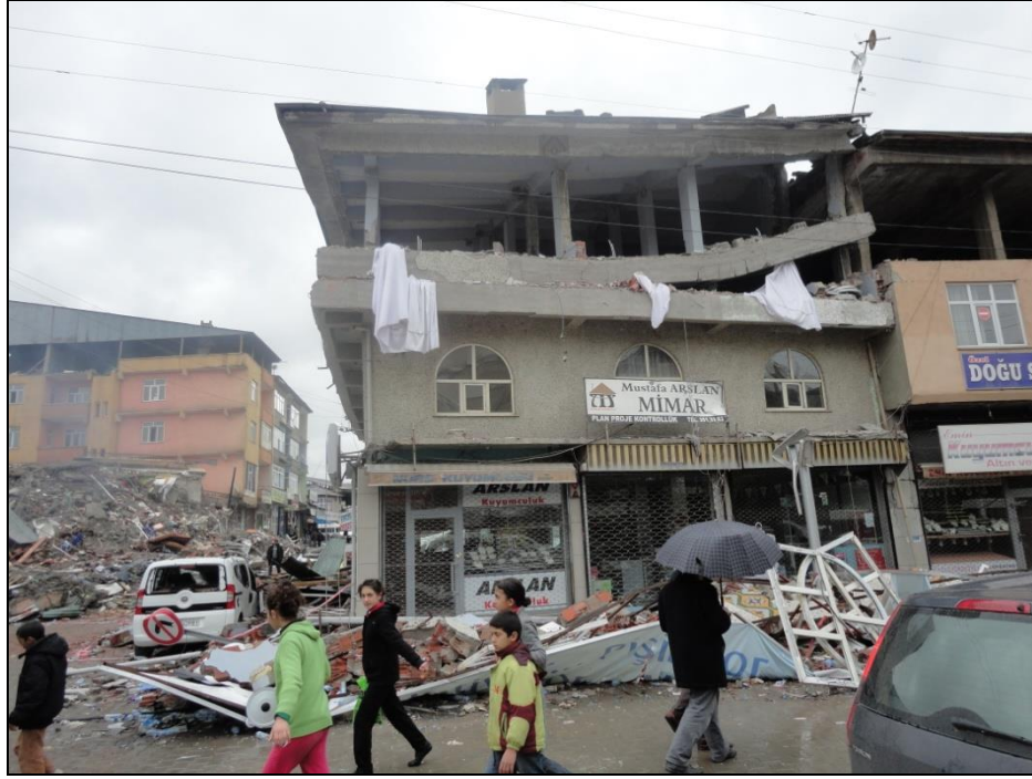
Şekil 1. Ara kattan dolayı oluşan deprem hasarı
