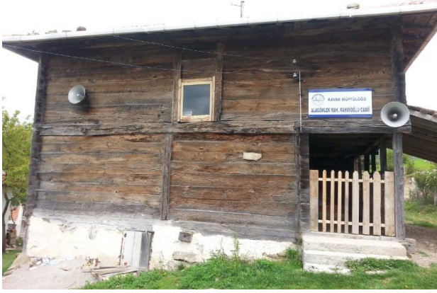
Resim 7: Alagömlük Köyü Rahmioğlu Mahallesi Camii'nin Güney Cephesi.
