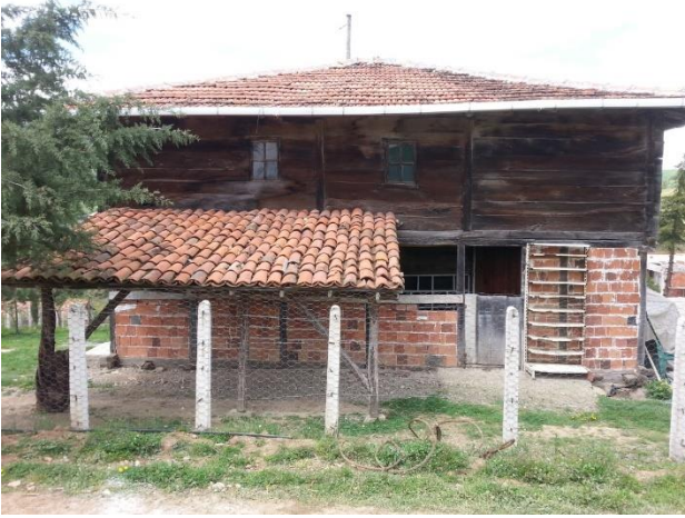
Resim 8: Alagömlük Köyü Rahmioğlu Mahallesi Camii'nin Doğu Cephesi.
