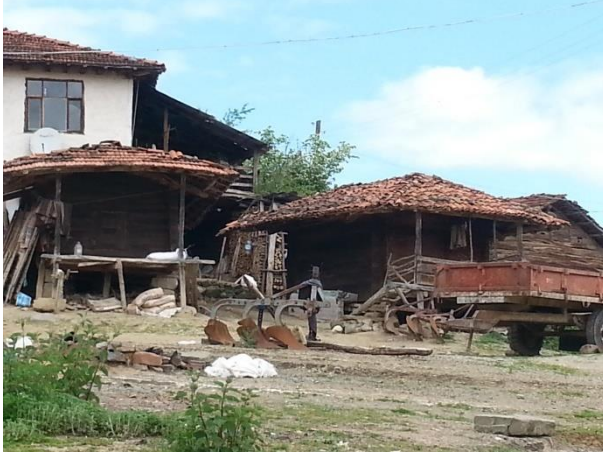
Resim 13: Alagömlük Köyü'ndeki Çantı Tekniğinde İnşa Edilmiş Ambarlar.
