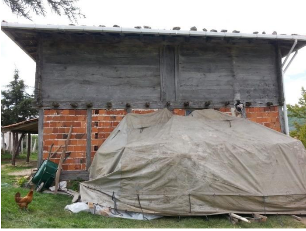
Resim 9: Alagömlük Köyü Rahmioğlu Mahallesi Camii'nin Kuzey Cephesi.
