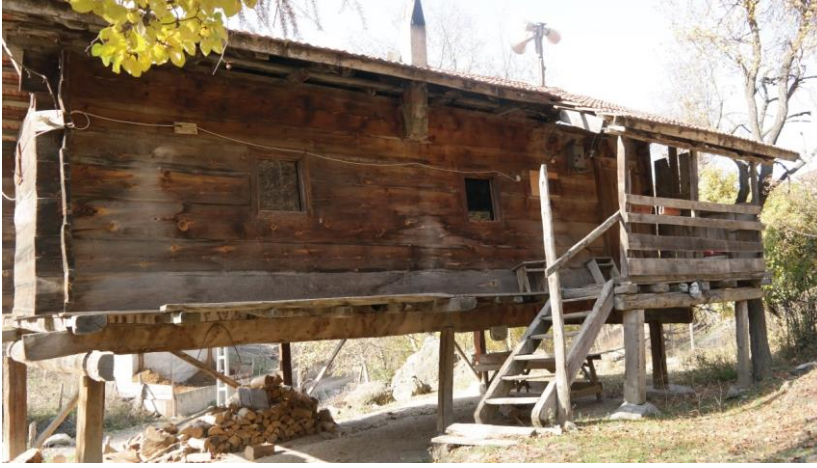
Resim 14: Susuz Köyü Merkez Camii'nin Doğu Cephesi.
