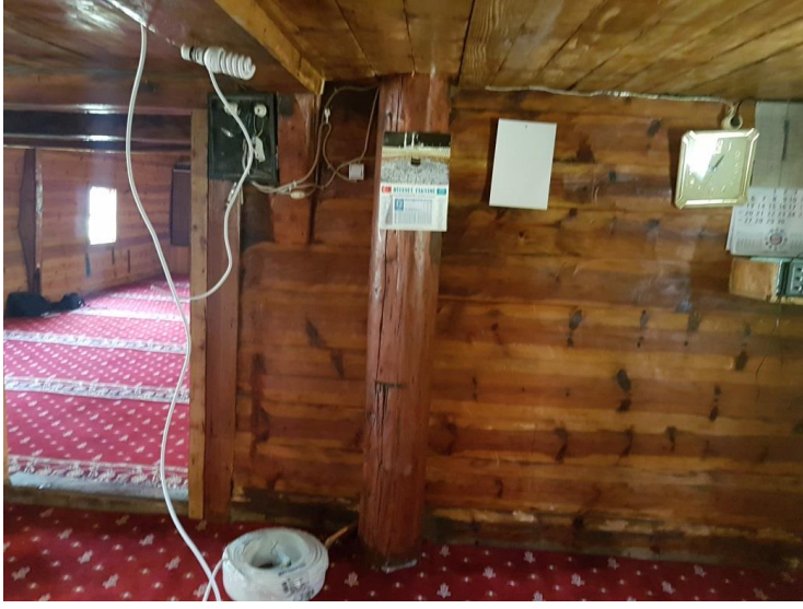
Resim 12: Çorakdere Köyü Corukdere Mahallesi Camii Minaresinin Mili.
