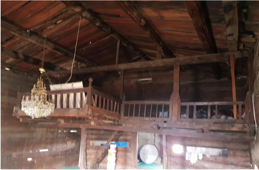
Resim 6: Karanar Köyü Camii'nin Mahfil ve Çatısından Görünüm.
