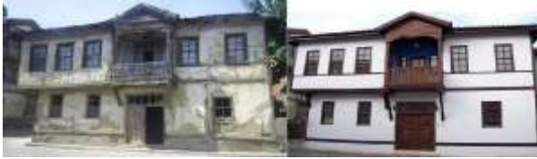
Şekil 2. Abdi İbrahim Konağı restorasyonu ("Abdi İbrahim Konağı", 2017)
