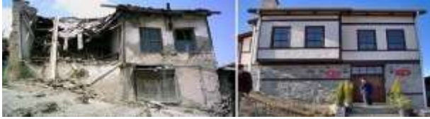
Şekil 3. Taraklı'da bir konut restorasyonu ("Taraklı restorasyon", 2017)
