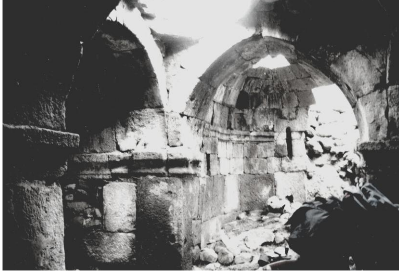
Resim 3- Niğde, Kitreli, Kilise, Naos, Naos, Kuzeydoğuya Bakış.
