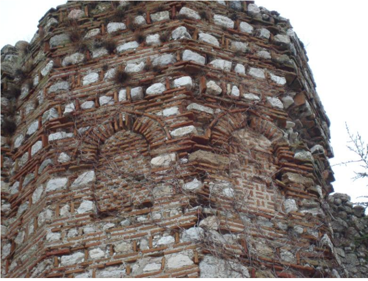
Foto. 16- Eğirdir Kalesi. Beşgen planlı burç üzerindeki sonradan kapatılmış pencereler
