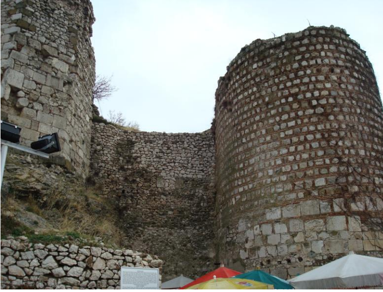
Foto.6- Eğirdir Kalesi. Moloztaş örgülü muhdes duvar.
