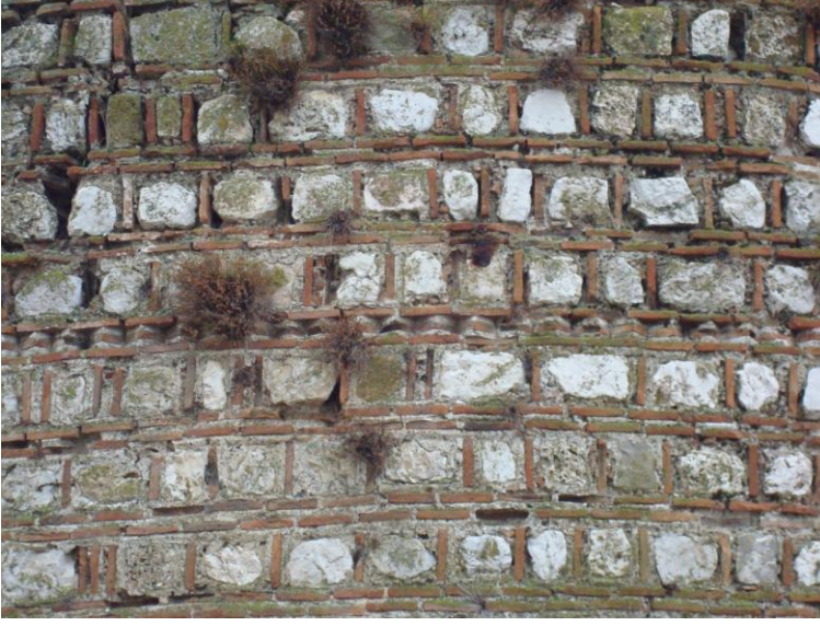
Foto.5- Eğirdir Kalesi. Almaşık duvar tekniği.
