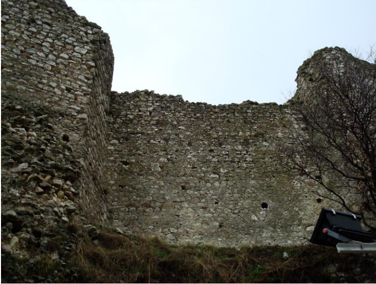
Foto. 20- Eğirdir Kalesi. Kalenin üst kesimindeki sur duvarı.
