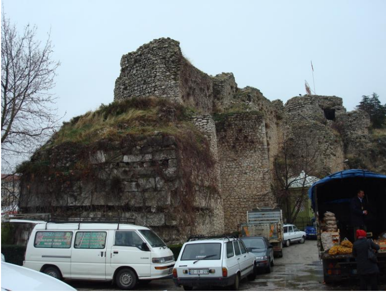
Foto.2- Eğirdir Kalesi. Güney köşesindeki poligonal burç.
