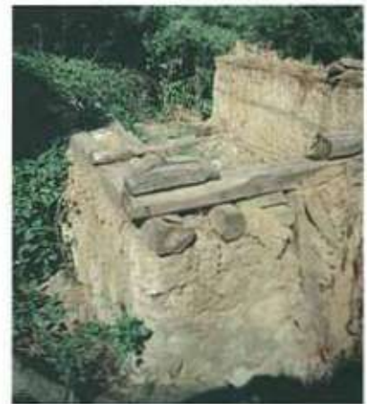
Res. 44. H22C001.041 envanter numaralı yapının güneyindeki ahşap yapının hatılı kerpiç duvarı.
