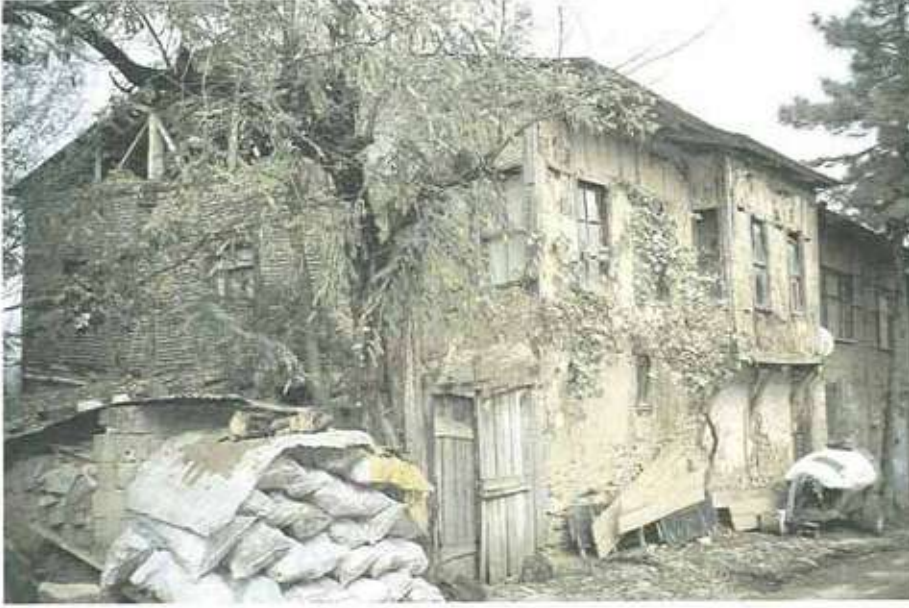
Res. 53. H22C001.092 envanter numaralı yapının sokak cephesi.
