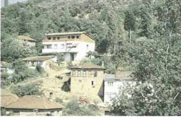
Res. 49. Köy içinde yeni betonarme yapılar.
