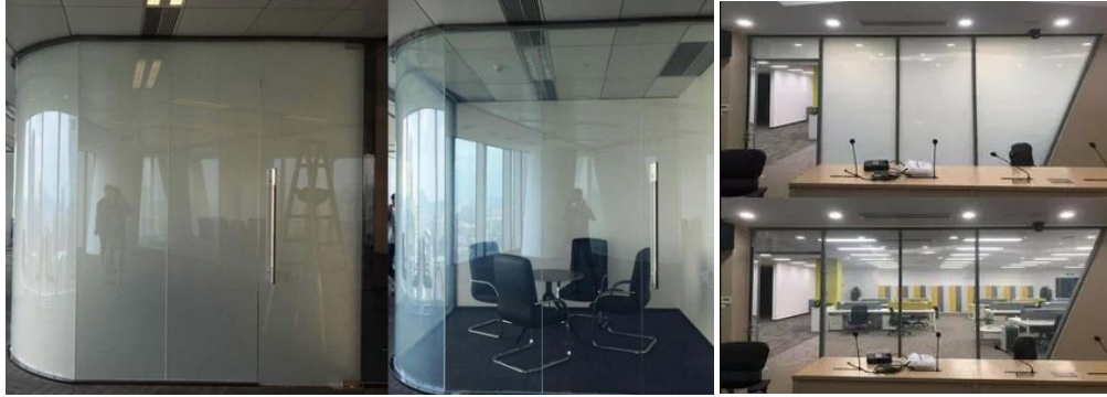
Görsel 5. Akıllı cam sisteminin çeşitli hacimlerde uygulama örnekleri. 8
