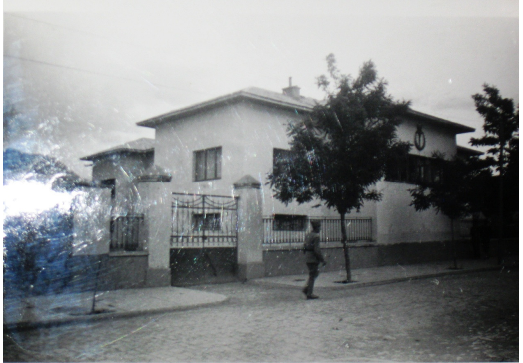
Van Halkevi Binası
