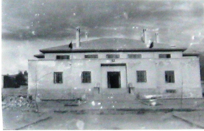
Van Halkevi Binası
