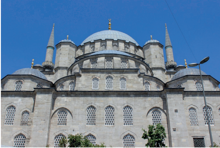
Görsel 5: Yeni Camii kible cephesi (Aysu Ateş, 2022).
