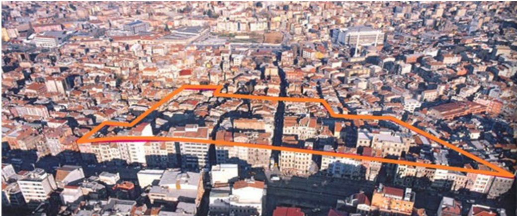
Şekil 5. Taksim 360 Projesi Öncesine Ait Tarlabası Bulvarı Hava Fotoğraf (Yiğit, 2011, s.105)
