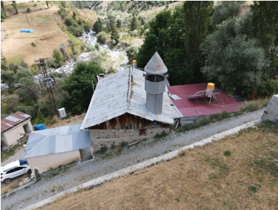
Görsel 6. Yapının Kuzey Cephesi
