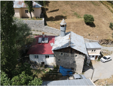
Görsel 4. Yapının Güney Cephesi
