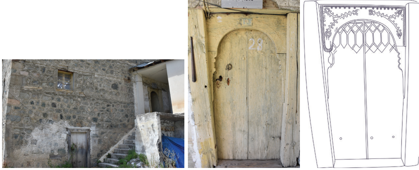
Görsel 14. Merdivenler ve Harim Giriş Kapısı
